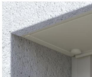
Prinzipdarstellung Friesaussparung
