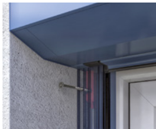
Standardbefestigung durch die Bohrung im Blendkappen-Zapfen
