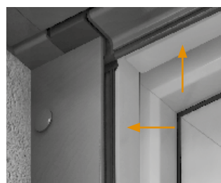
Spaltabdeckung bei Einsatz einer Führungsschiene für Multifunktion (XP-Baureihe mit Insektenschutzgitter oder Screen), jedoch noch ohne Einsatz derselben.
