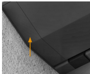
17 mm Fries für eine funktionierende Revision des Elements
