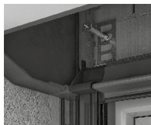
Kastenzusatzbefestigung bei Panzergewicht über 20 kg (Abb. XP-System)
